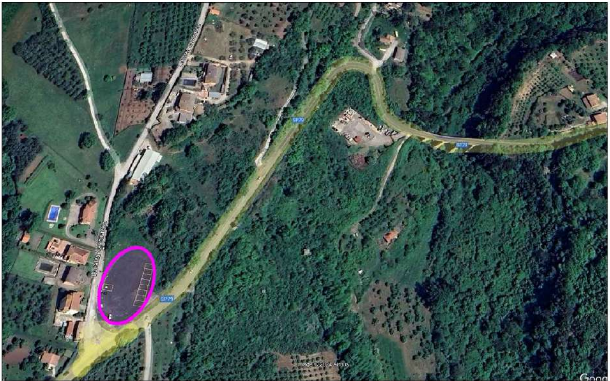
PARCHEGGIO SULLA SP79 LATO DX OLTRE IL PONTE direzione Calcata
